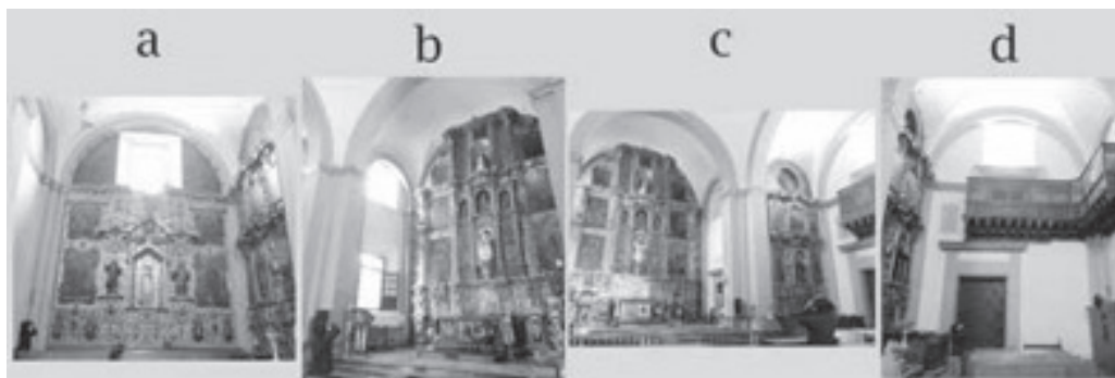
Imagen 13. Grupo de imágenes que muestran: a. El transepto de la izquierda con ventana y dos retablos. b. El altar principal con dos ventanas en el lateral, una abierta en la zona inferior. c. El altar principal, la entrada a la sacristía y el transepto de la derecha. d. El transepto de la derecha con un retablo, una puerta de entrada al convento, la celosía en la zona superior y un confesionario en la zona inferior.
